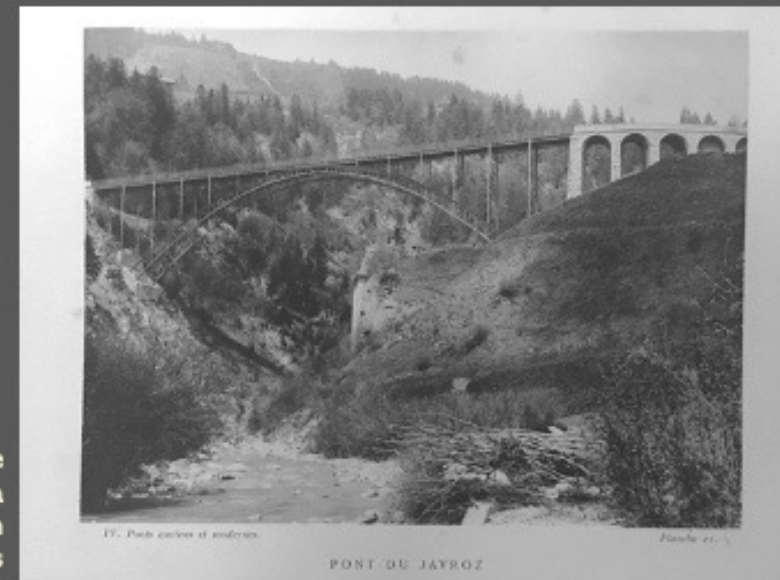
Sur cette photo du début du XXe siècle, on aperçoit clairement la culée Est, rive gauche, de l'ancien pont couvert en bois
