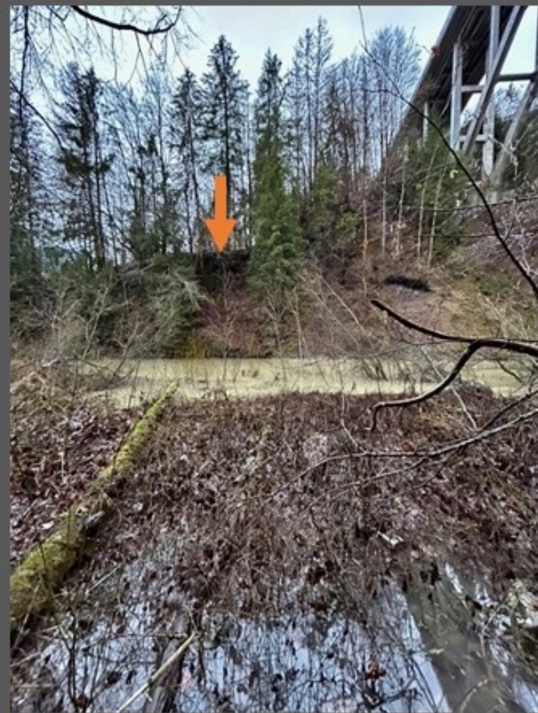
L'éperon rocheux et la culée de la rive droite sur lequel s'appuyait de ce côté le pont de 1854
