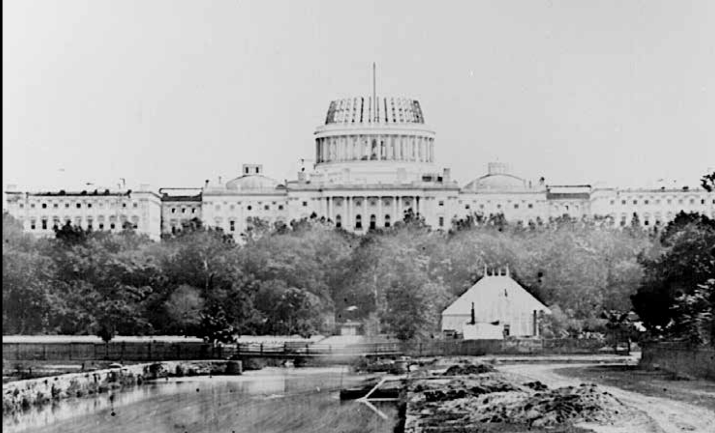
Le dôme du Capitole en construction (1860)
