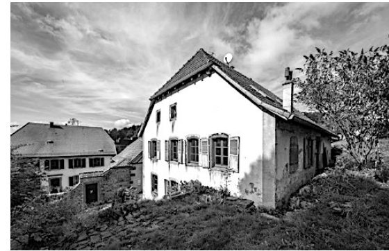
Presbytère (1787) et maison-école de Waldersbach – Alsace
